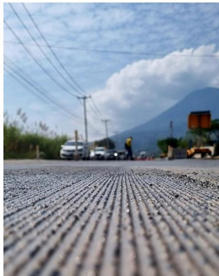
**FIGURA 1 ACABADO SUPERFICIAL DIAMOND GRINDING.**
